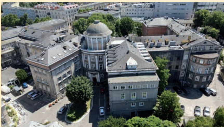
Lokalizacja inwestycji przy ul. Długiej 1/2 – zrealizowane zostaną prace dociepleniowe, modernizacja instalacji (grzewczej, ciepłej wody użytkowej, wentylacji mechanicznej, oświetleniowej), montaż instalacji PV i stacji ładowania pojazdów elektrycznych
