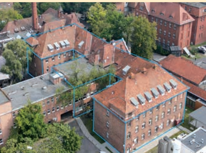
Lokalizacja inwestycji przy ul. Przybyszewskiego 49 – zrealizowane zostaną prace dociepleniowe, dodanie pomp ciepła do istniejącego systemu c.o., modernizacja instalacji (grzewczej, ciepłej wody użytkowej, wentylacji mechanicznej, oświetleniowej), montaż instalacji PV, wymiana windy, montaż urządzenia do magazynowania energii, remont łazienki oraz montaż systemu do zarządzania budynkiem
