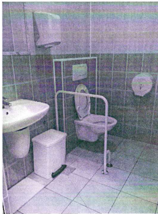
Zdjęcie nr 2 - Przykład toalety niespełniającej standardów – nieskładany uchwyt od strony przesiadania
