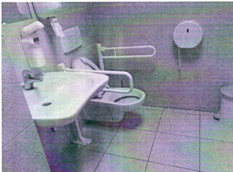
Zdjęcie nr 3 - Przykład toalety niespełniającej standardów – brak przestrzeni do przesiadania się
